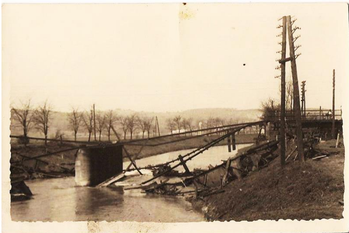
Němci zničený železniční most přes řeku Dřevnici
